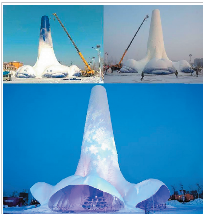
Рисунок 7. Создание ледовых куполообразных конструкций с использованием надувной опалубки [56] Figure 7. Creation of ice dome structures with the help of inflatable formwork [56]
