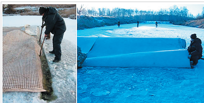
Рисунок 1. Погружение геокомпозита в «майну» и протаскивание его под льдом капроновыми тросами («нижнее» армирование)
